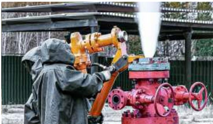
Ежегодно на специализированных полигонах, а так же на скважинах, в условиях, максимально приближенных к реальным, проводятся учения по отработке устьевых операций по ликвидации открытого фонтана. А так же испытание нового специального оборудования и приспособлений, разработанных в целях усовершенствования и повышения безопасности проведения аварийных работ.
